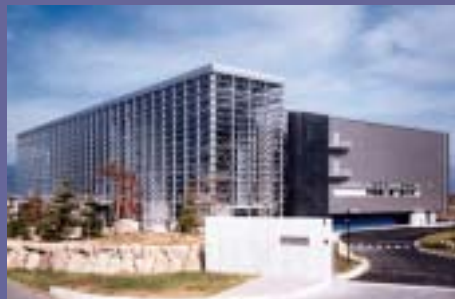
郊外型データセンター
