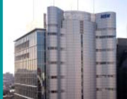
都市型データセンター
