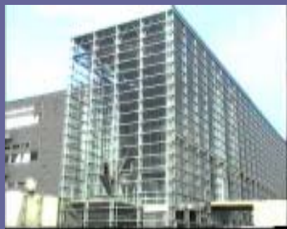
郊外型データセンター
