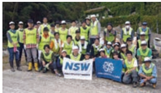
被災地でのがれき撤去を実施
